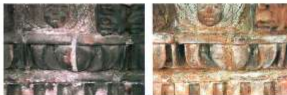
Verifica della rimozione dei prodotti di degrado in seguito a pulitura
